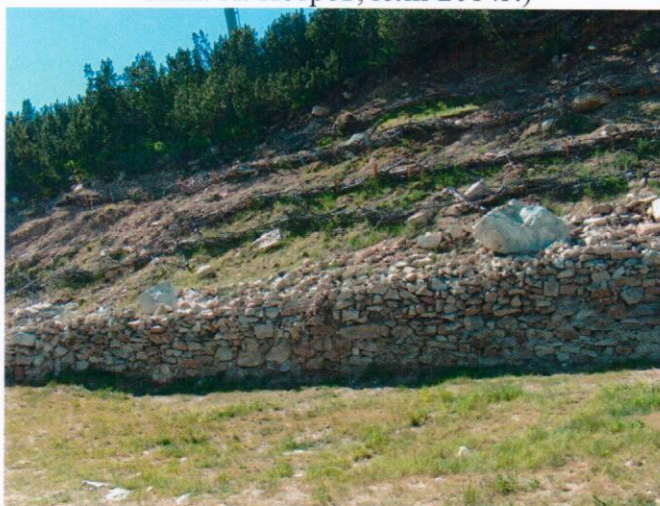
Сн.6: Суха каменна зидария при долна станция на лифт „Бъндеришка поляна-Междинна станция“ (сн. инж. И. Петров, юли 2014г.)
