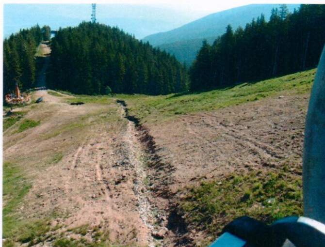
Сн.4: Канавка-колектор, пресичаща ски-писта „Томба“ (сн. инж. И. Петров, юли 2014г.)
