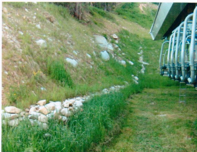
Сн.5: Суха каменна зидария при долна станция на лифт „Бъндеришка поляна-Старата писта“ (сн. инж. И. Петров, юли 2014г.)
