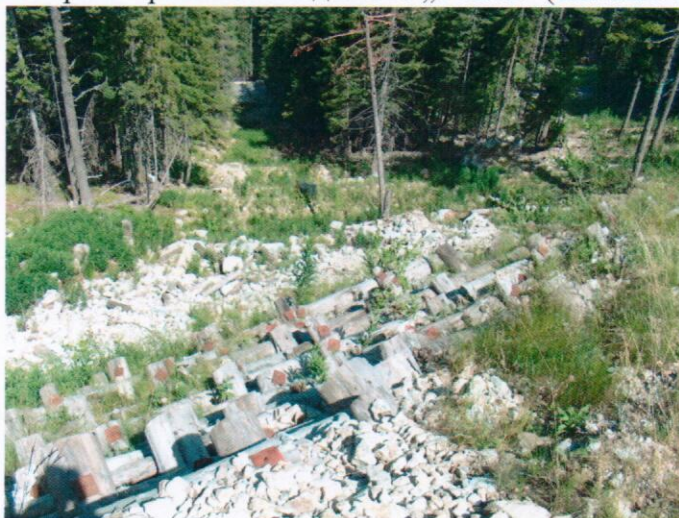
Сн.8 Подпорна стена под писта „Томба“ (сн. инж. И. Петров, юли 2014г.)
