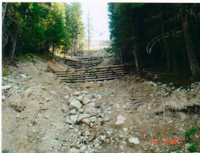
Сн.7 Двустенен дървен бараж – ровината под писта „Томба“ (сн. инж. И. Хаджиев, 09.2011г.)
